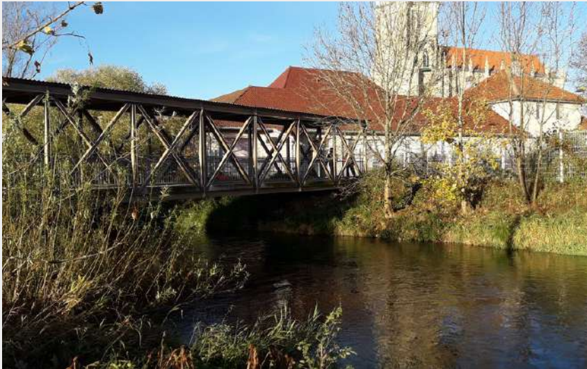
Passerelle de Doubs (CCGP)
